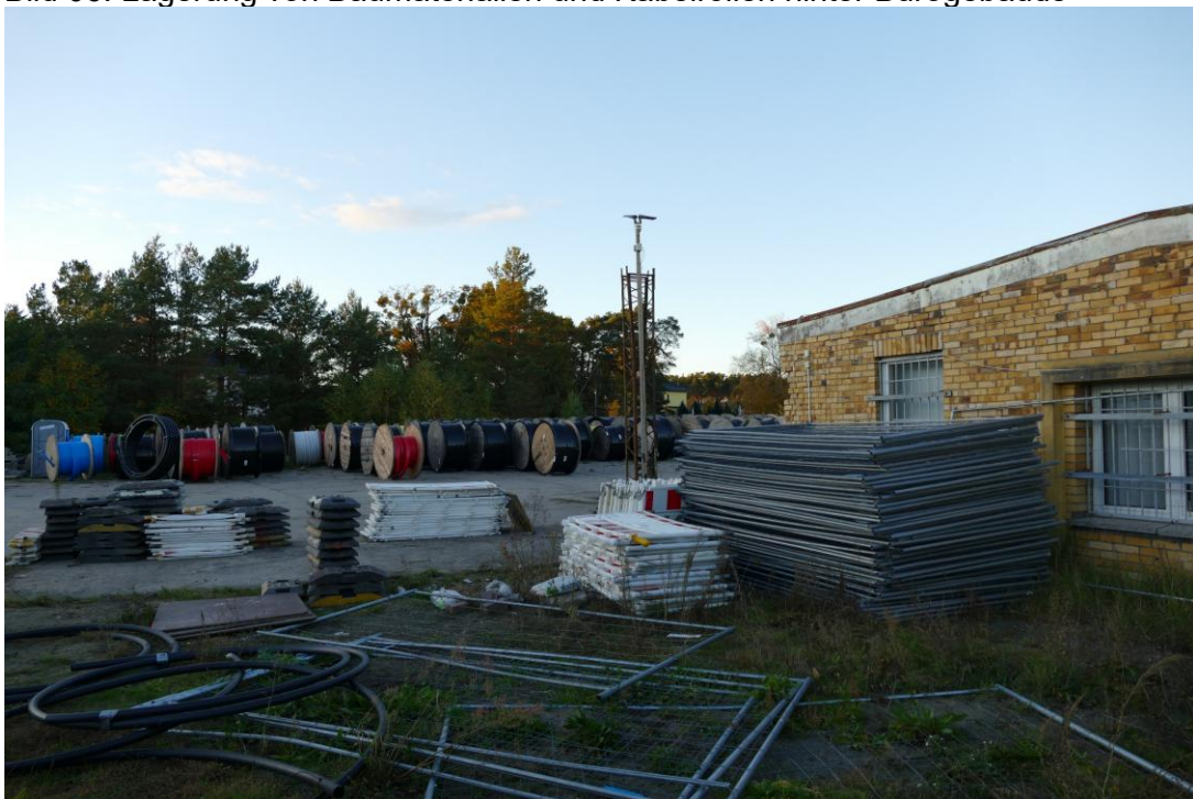
Bild 06: Lagerung von Baumaterialien und Kabelrollen hinter Bürogebäude
